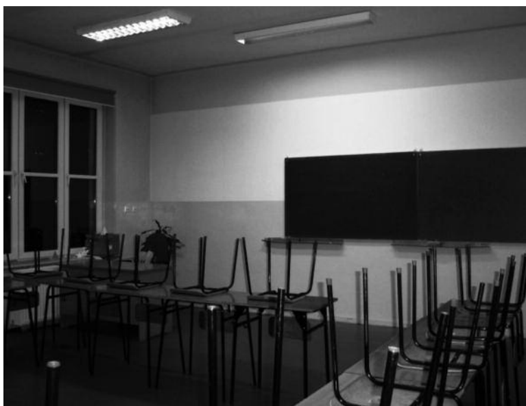
Ryc. 3. Przykład nieefektywnego zastosowania dodatkowego oświetlenia tablicy
