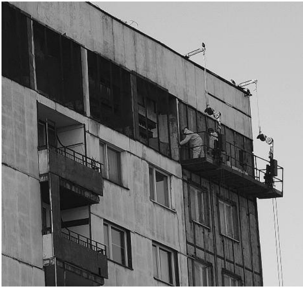
Ryc. 1. Przykład prac demontażowych na wielokondygnacyjnym budynku, ocieplonym wełną mineralną i płytami azbesto-cementowymi (fot. G. Szał)
